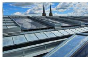
Panneaux gris, intégrés sur pan en zinc Metz (57)
