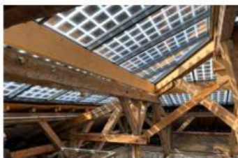
Panneaux translucides formant verrière Metz (57) / © Artech Architectes
